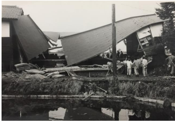
【 倒壊した建物 】
