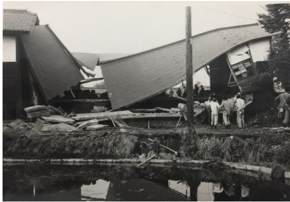
【 倒壊した建物 】
