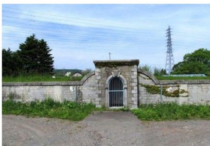
坂の上配水池
