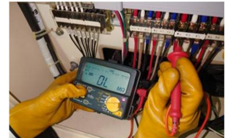
写真1 絶縁抵抗測定の様子
