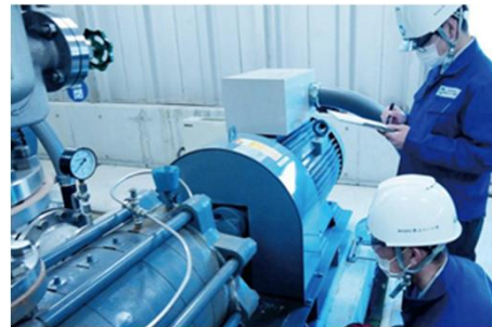
新大久保配水池 (施設点検)
