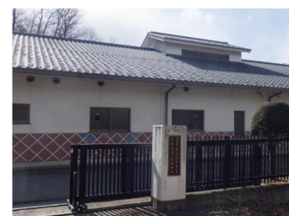
耳取農業集落排水処理施設
