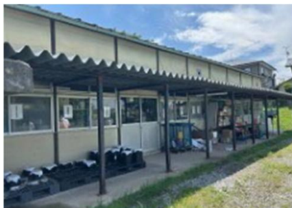
坂の上配水池 備蓄倉庫
