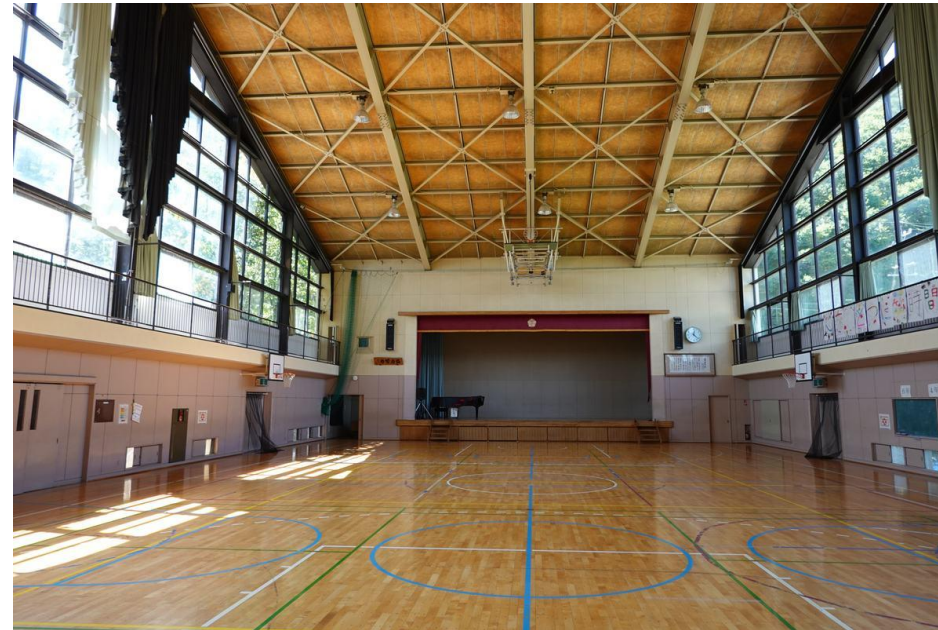
体育館（木造トラス）
