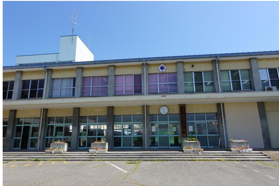
校舎外観（昇降口側）
