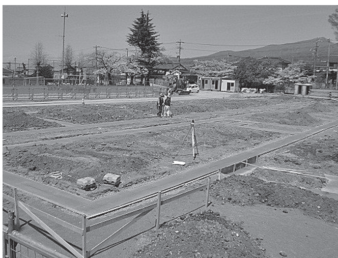
仮設校舎設置工事の様子
