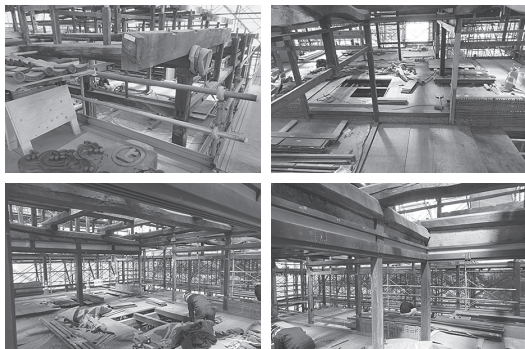
復原工事中の旧小諸本陣
