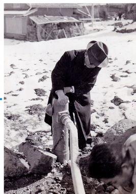
▲ 宮沢簡易水道の通水試験(昭和 33 年)
