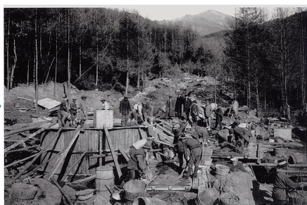
▲ 野馬取水源集水井築造の様子(大正 12 年)
