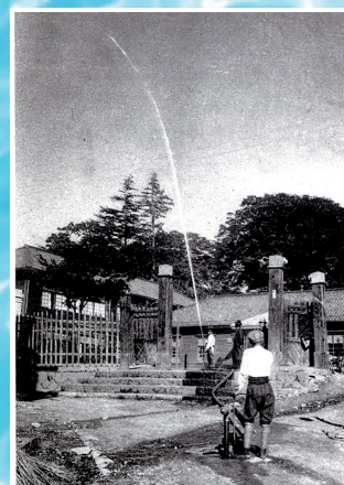
▲ 小学校放水試験
