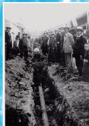
▲ 本町配水管埋設工事（大正 13 年）
