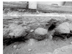
主屋の土台下から出土した浅間石 (写真提供 深谷市渋沢栄一記念館)
