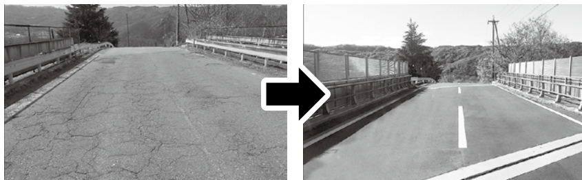
国補道路メンテナンス事業 狐原橋 道路橋補修工事 (市道0128号線)
