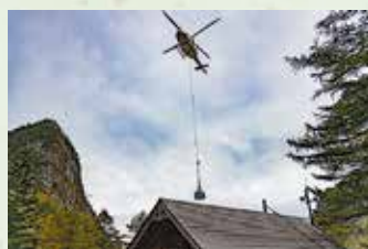
火山館トイレ バッテリー交換
