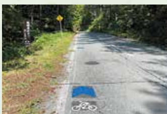
矢羽根型 路面表示の設置
