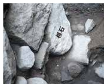
地盤沈下を防ぐため設置された石。
