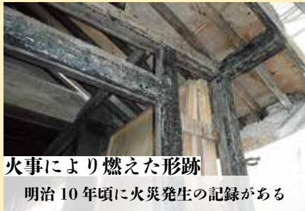
主屋一階 内外壁、造作が取り外された状態
