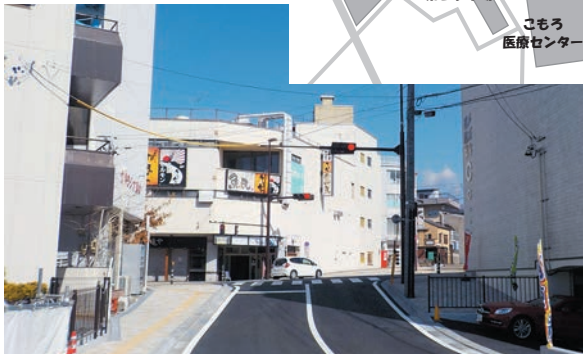
現在建設中の「こもテラス」側から撮影
