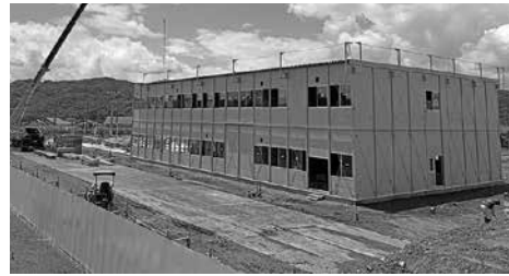
工事中の 仮設校舎
