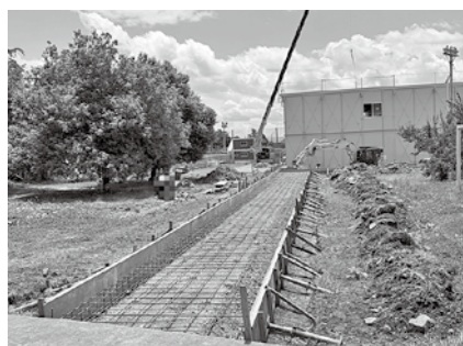
体育館と仮設校舎をつなぐ渡り廊下
