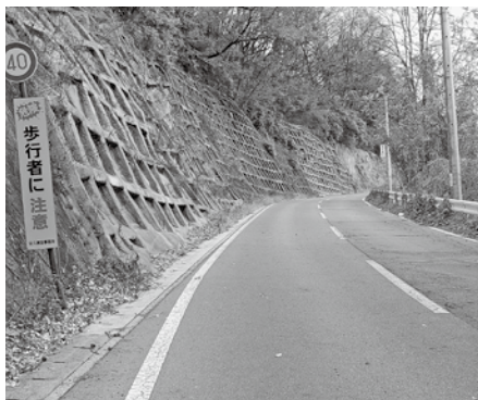
通学路となる歩道が無い県道（大久保側）
