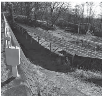
市道に面したガイドライン要項違反現場
