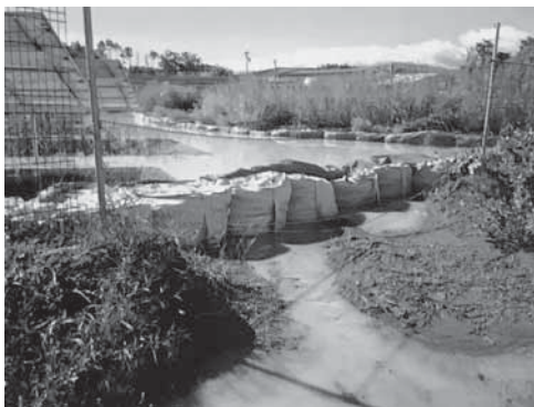
平成18年の豪雨災害のあった設置場所
