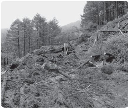
土砂崩れの災害現場
