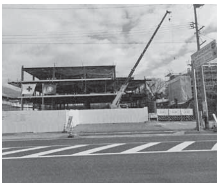
工事が進む 新小諸消防署庁舎
