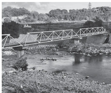
小諸浄化センターへの水管橋
