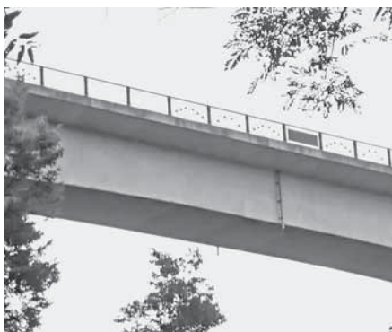
下から見た小諸大橋
