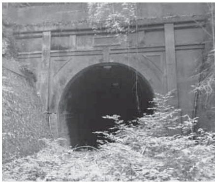
活用が期待される旧宮沢トンネル
