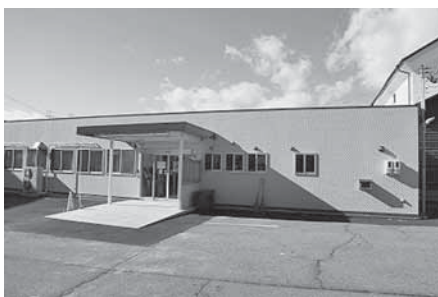
「(株)水みらい小諸」の仮事務所 (旧臨時図書館)
