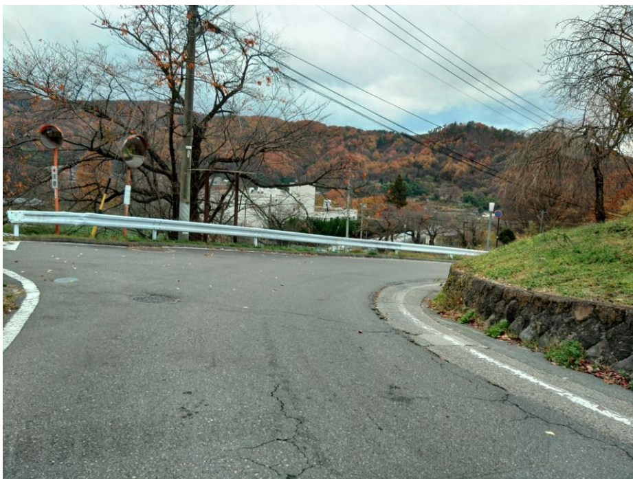
写真4 児童遊園地下のカーブ 県道八幡小諸線
