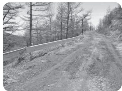
湯の丸高峰併用林道 標高1,730m~2,040m延長8km
