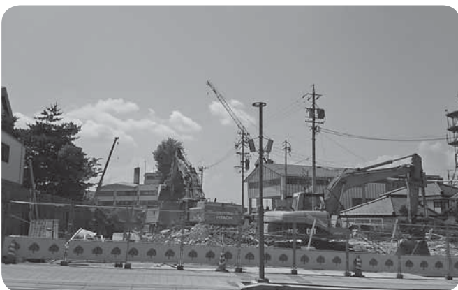
工事が進むあいおい公園
