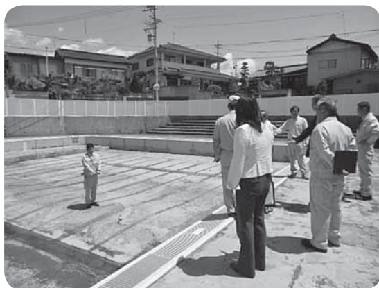
学校施設点検 (野岸小プール)
