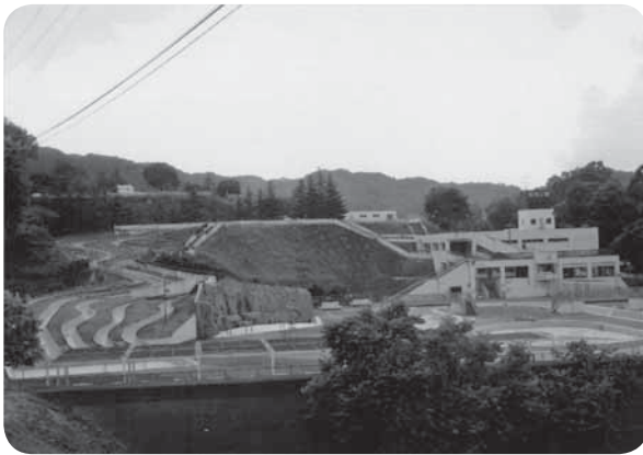
南城公園プール
