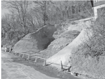
御影用水越流箇所の法面復旧工事
