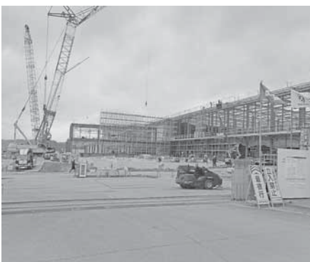
工場建設が進む和田工業団地
