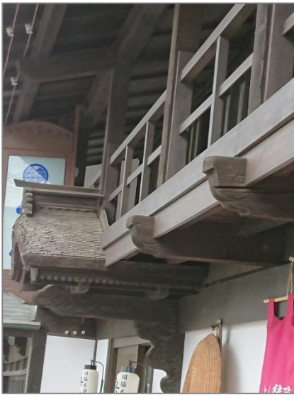
脇本陣柔屋 2階「出梁造り」
