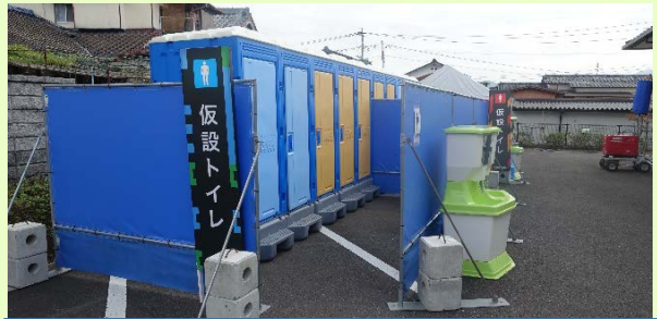
仮設トイレ設置
