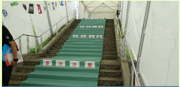
臨時仮設物の整備 仮設通路の設置
