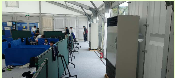
仮設エアコンの設置
