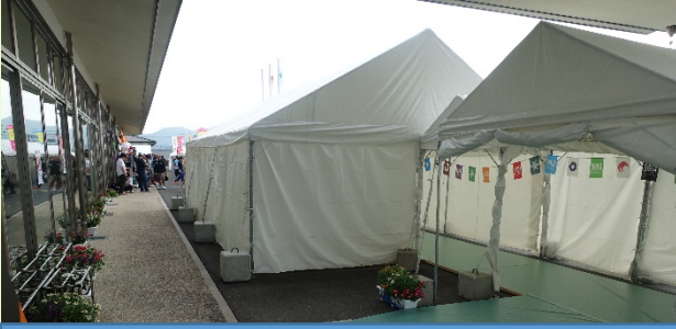
臨時仮設物の整備 仮設テント設置
