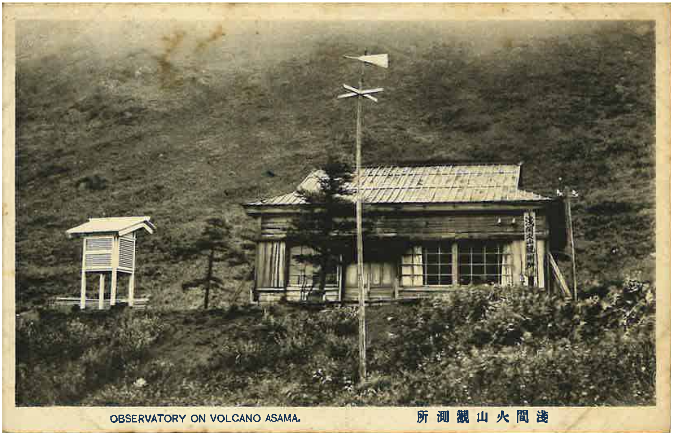
浅間火山観測所（湯の平）建物正面外観全景（増築前）_ 絵葉書
