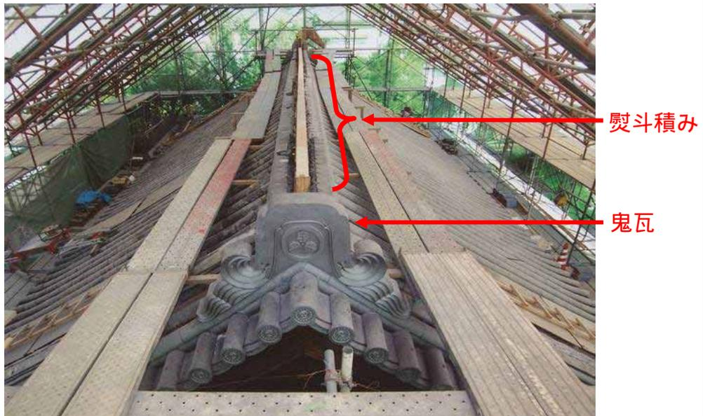
屋根へ大棟の鬼瓦と熨斗積みを施工しています。
