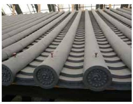
本瓦平葺の施工中です。 軒丸瓦へ瓦釘を取付けています(南面)。
