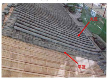
本瓦平葺の施工中です。 平瓦は 1/3 程度が重なっています。平瓦の上は丸瓦です。
