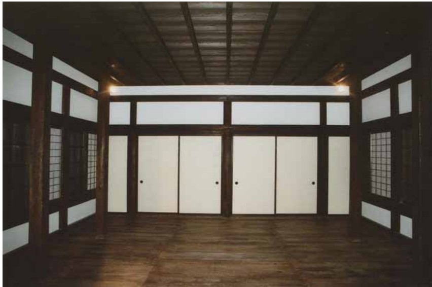
2 階内部 東室西面
