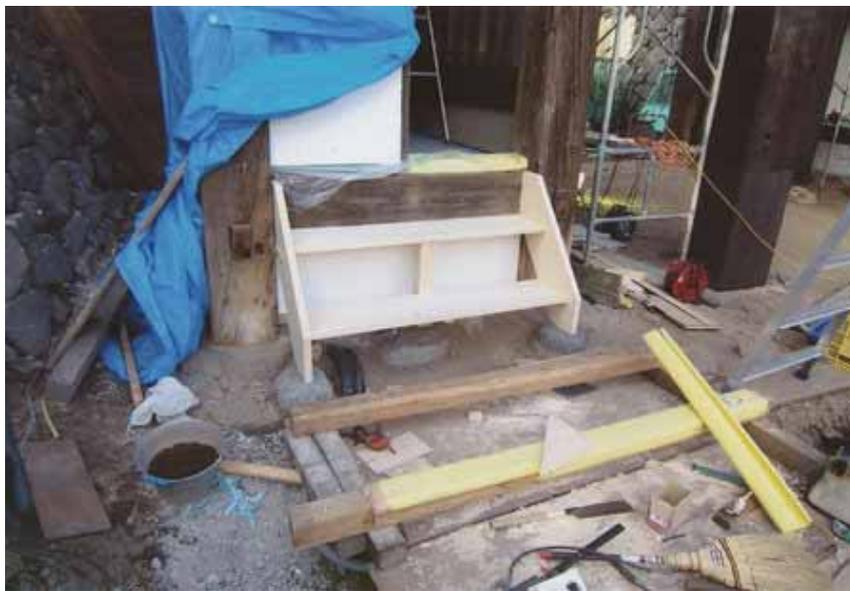
西番人部屋の出入口に筋桁（ささらげた）階段を組立てています。
