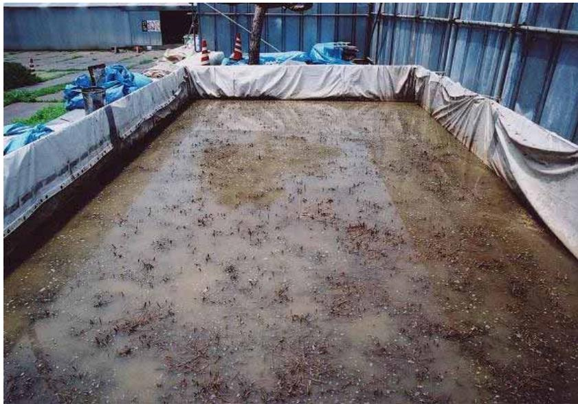
解体時に取っておいた旧荒壁の土に新藁スサを混入し、
