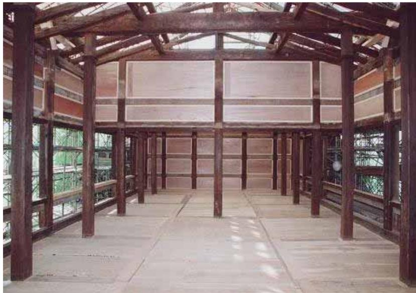
2 階への敷鴨居と構造用合板の取付けをしています。
