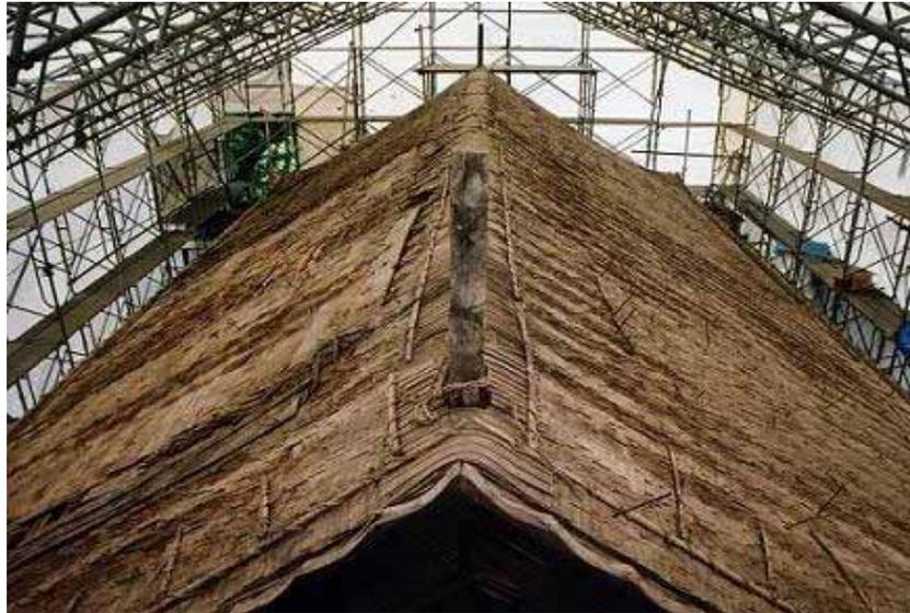
筋置き葺土を取外した土居葺きの状態です。
