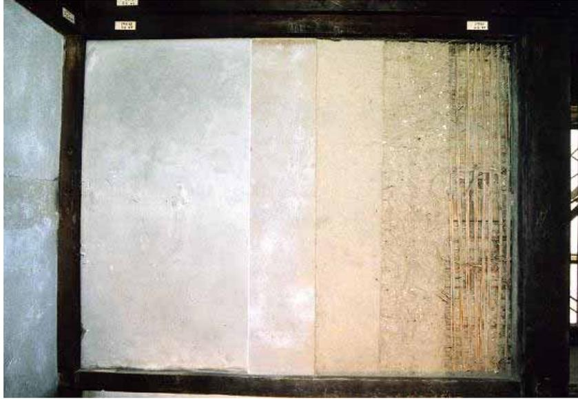
2 階北面西端間の壁塗工程が分るよう、少しずつ剥がしてみました。
