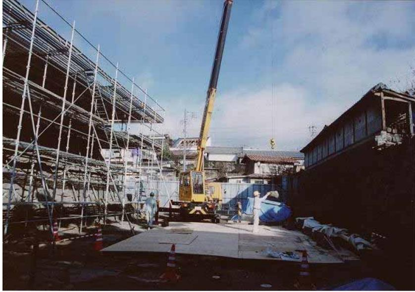
西側石垣に足場を組み、クレーンで石を取り外しています。
