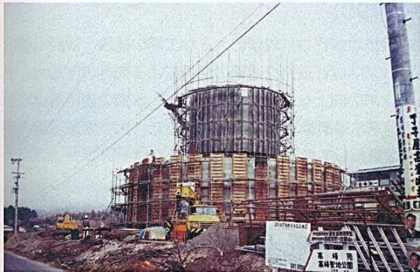
中央配水池建設の様子 (昭和 52 年)
