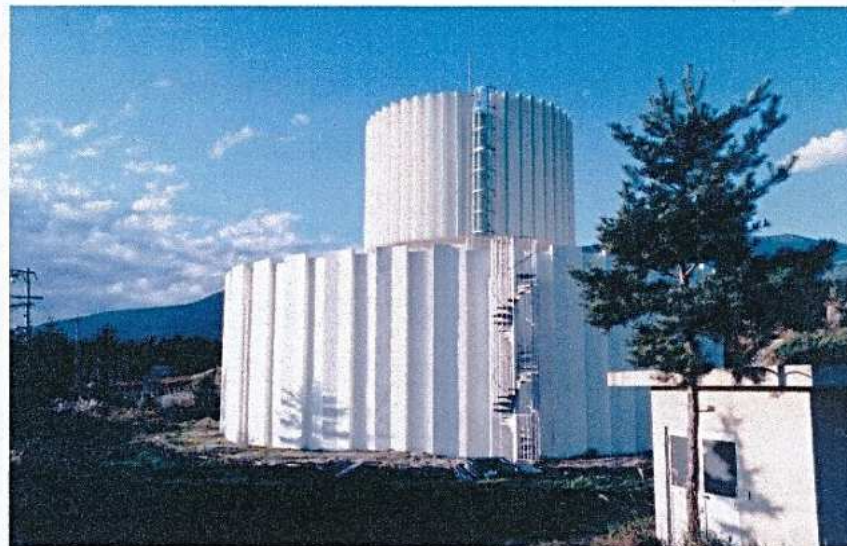
中央配水池竣工 (昭和 52 年 10 月)
