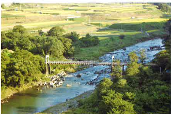
千曲川に掛かる吊り橋
