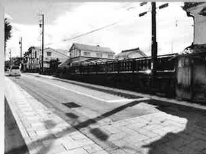
設置した板塀
