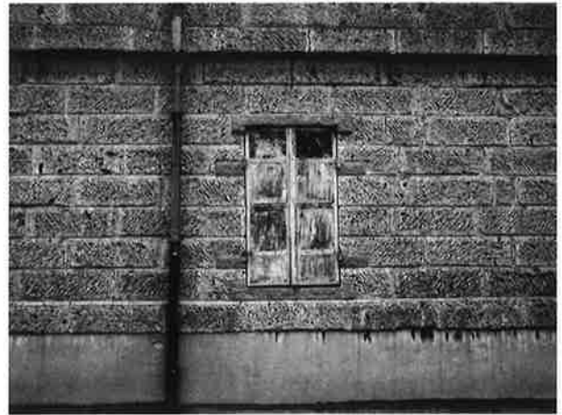
自然石（大谷石）を利用した壁
