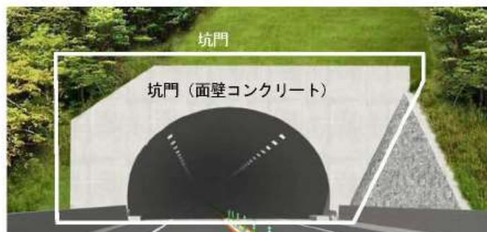
トンネル坑口部
