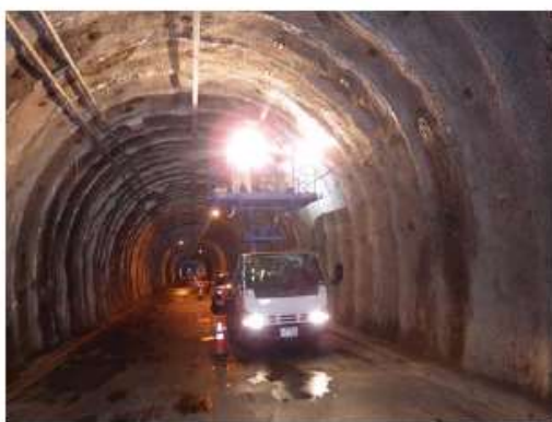
(参考) 点検状況
