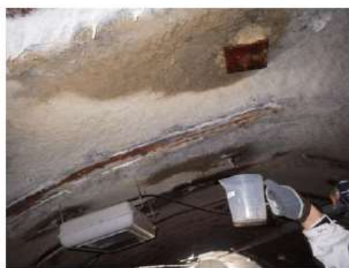
(参考) 漏水調査状況
