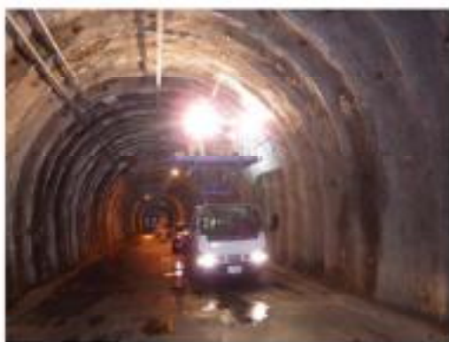
(参考) 点検状況
