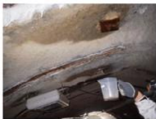
(参考) 漏水調査状況
