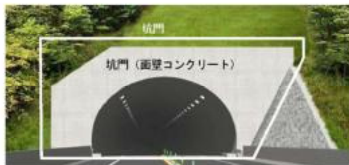
トンネル坑口部
