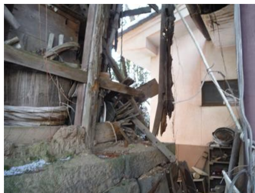
【柱「著しく破損している」の例】
