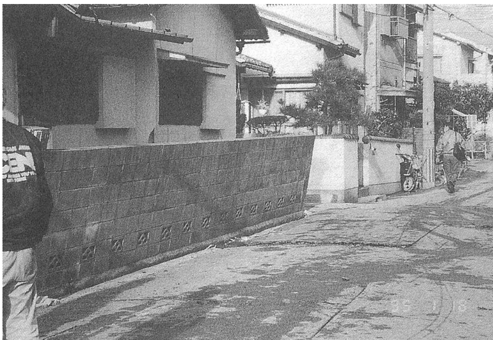
【転倒危険物（ブロック壁）】
