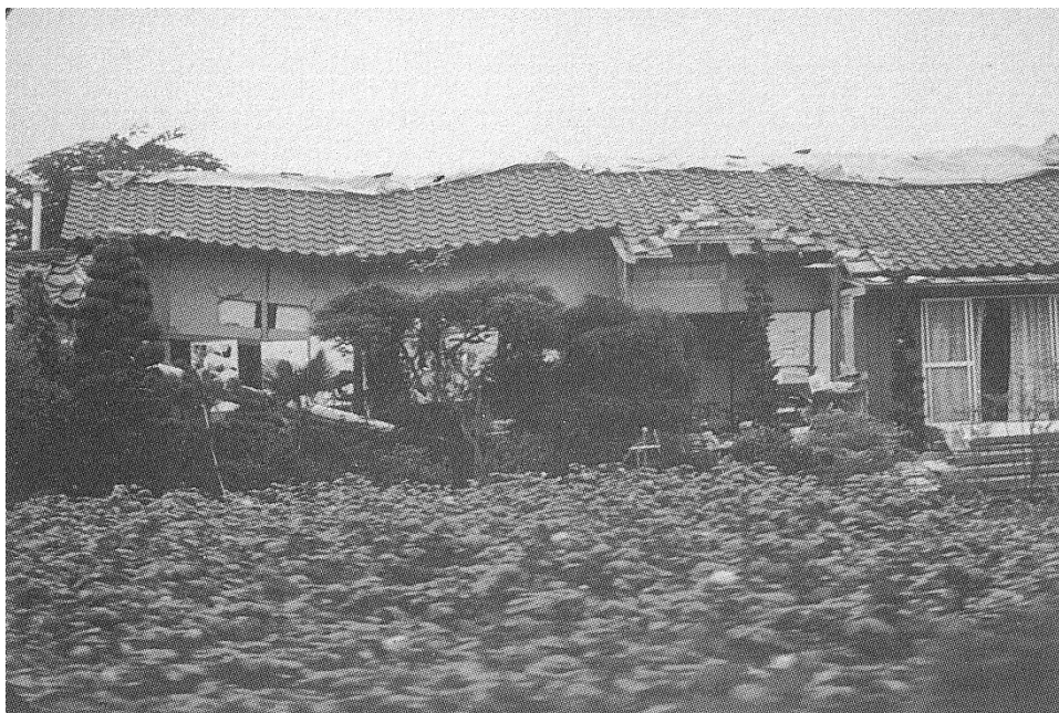
【建築物の不同沈下】
