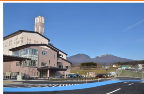
ごみ焼却施設 クリーンヒルこもろ
