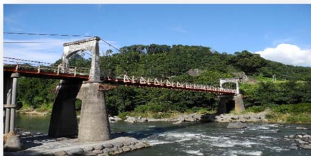
千曲川に架かるつり橋（大杭橋）
