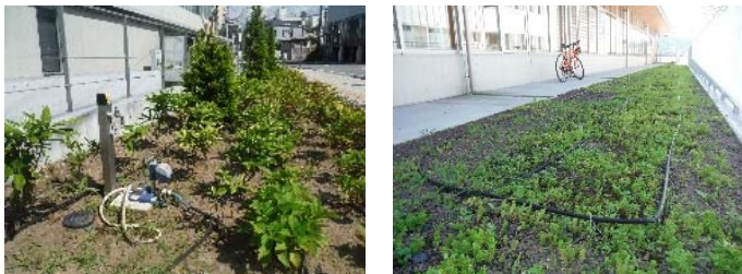
雨水利用（植栽用散水設備）
