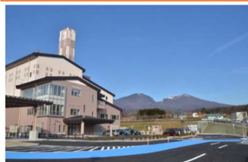
ごみ焼却施設 クリーンヒルこもろ
