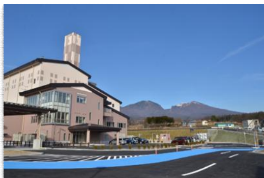
ごみ焼却施設 クリーンヒルこもろ
