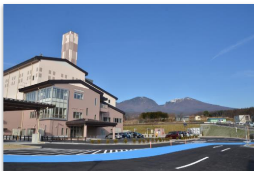
ごみ焼却施設 クリーンヒルこもろ
