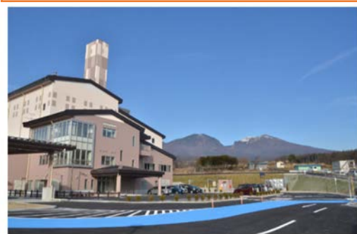
ごみ焼却施設 クリーンヒルこもろ
