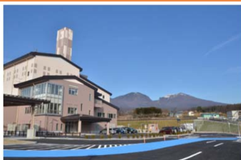
ごみ焼却施設 クリーンヒルこもろ
