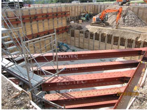
新ごみ焼却施設工事写真（1）
