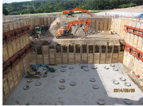
新ごみ焼却施設工事写真（2）
